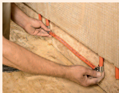
3 Die Wandheizungselemente wurden miteinander verbunden und an den Heizkreisverteiler angeschlossen.
