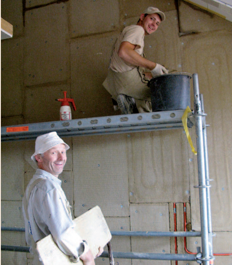
1 Links: Die 25 mm starken Klimatelemente aus Lehm wurden an den Brettsperrholzwänden befestigt.
